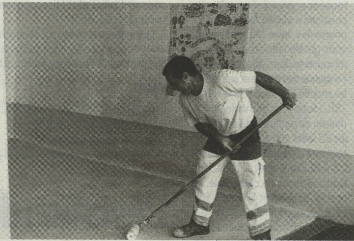
Réfection du sol du préau par l'employé municipal. © CHRISTIAN MARANCI
